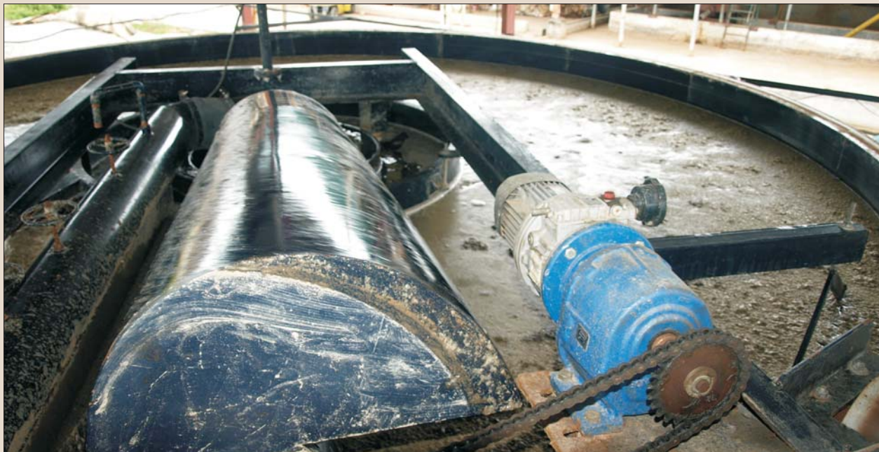
Hệ thống tuyển nổi thu hồi bột giấy trong nước thải xeo
