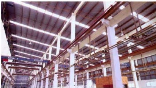
Hình 13. Chiếu sáng tự nhiên bằng mái che cacbonat tổng hợp
