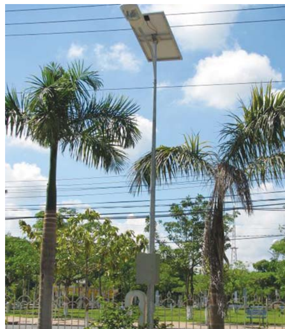
Mô hình chiếu sáng công cộng đèn LED sử dụng năng lượng mặt trời.
