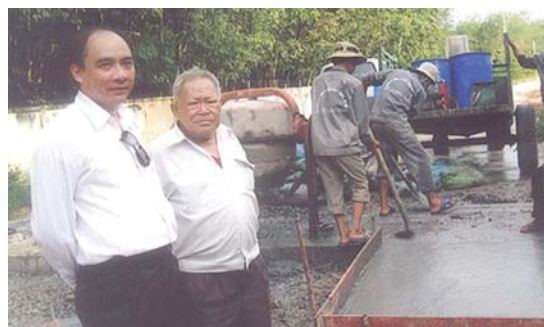
Tiến sĩ Nguyễn Hồng Bình (người đứng thứ hai từ trái qua), giám sát đổ bê tông đường nội bộ tại Xí nghiệp Xử lý chất thải Bình Dương.
