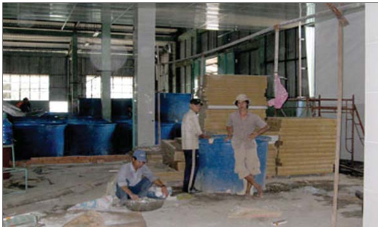
Một số giải pháp SXSH được triển khai hiệu tại Nhà máy chế biến dừa Thành Vinh.
