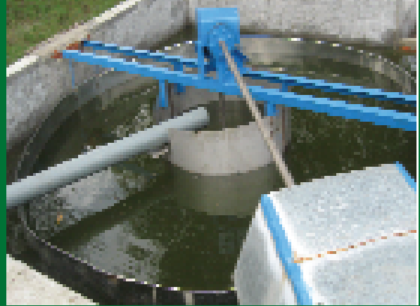
Xí nghiệp đã đầu tư lắp đặt bể tẩy mây mới bằng inox.
