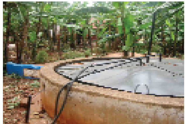
Công trình hầm ủ biogas mang lại nhiều tiện ích.
