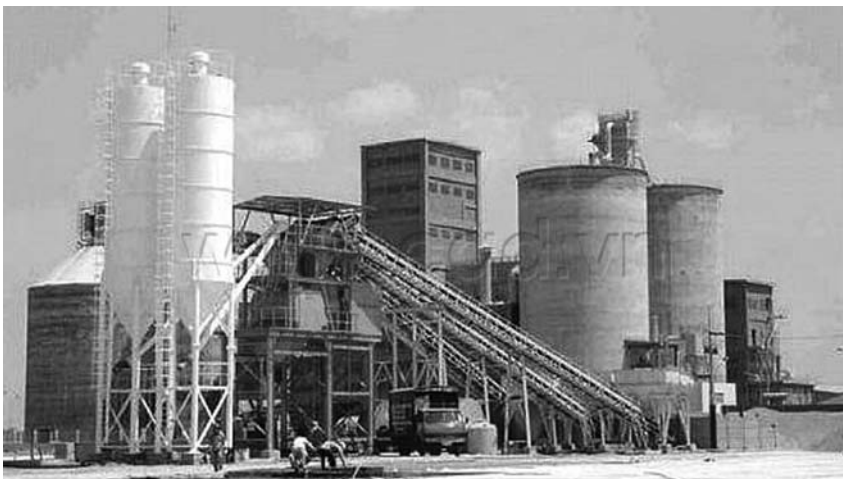
Sử dụng nhiệt khí thải của lò nung clinker xi măng để phát điện sẽ giúp tiết kiệm 25% lượng điện tiêu thụ từ lưới điện.
