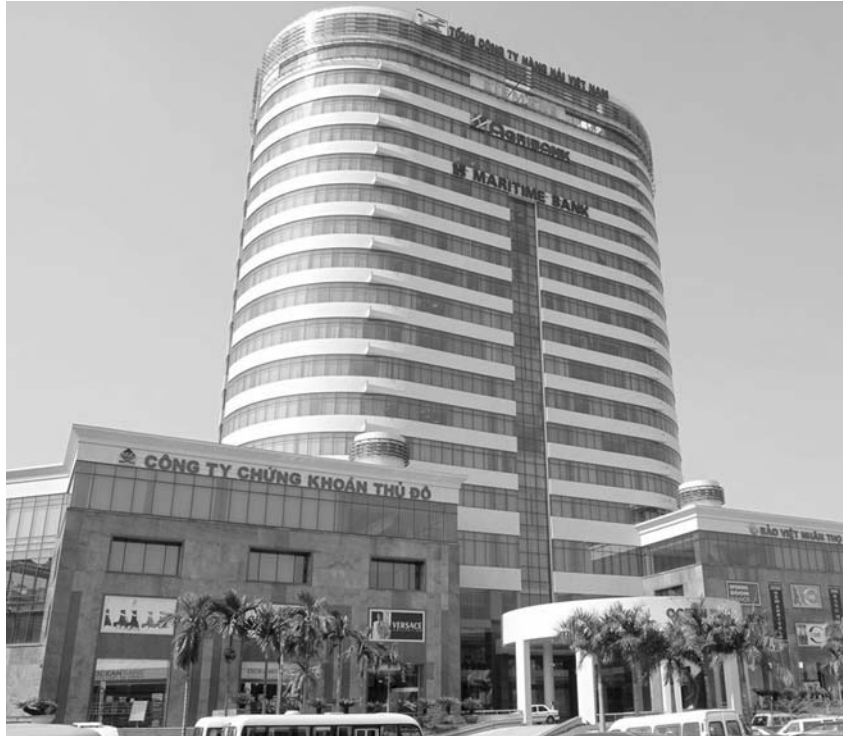
Tòa nhà Ocean Park (Hà Nội) - một trong những công trình sử dụng năng lượng hiệu quả.
