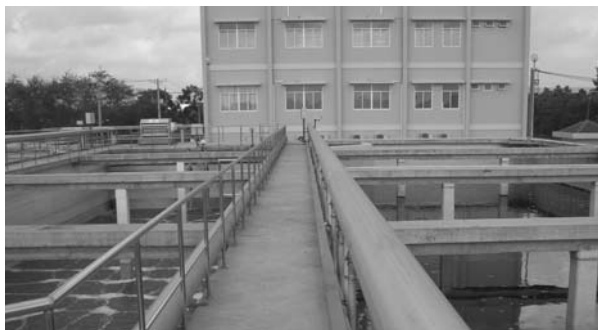
Nhà máy xử lý nước thải tập trung tại KCN Vĩnh Lộc - TP.HCM hoạt động hiệu quả.
