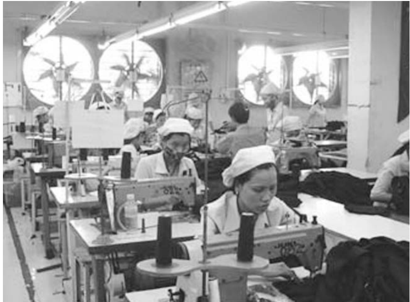
Công ty Dệt may Hòa Thọ lắp đặt các tấm tản nhiệt và hệ thống hút gió tại các chuyền may.
