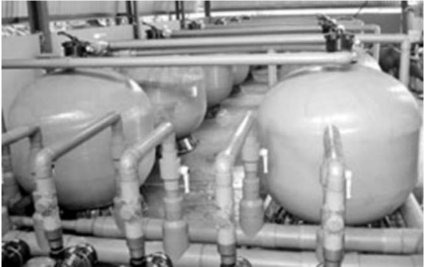
Hệ thống xử lý nước thải hầm lò của Công ty CP Than Hà Lâm.
