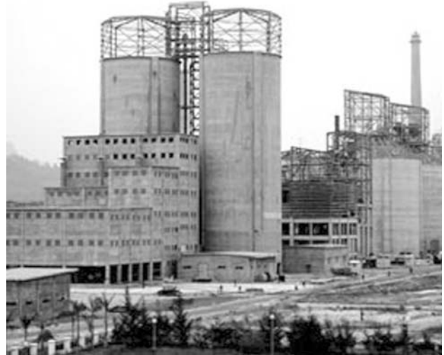
Nhà máy xi măng Hạ Long.
