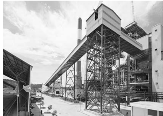
Nhà máy Nhiệt điện Ung Bí, Quảng Ninh.
